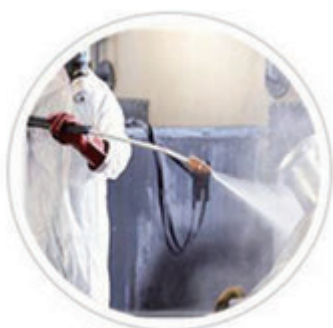
化学腐蚀清洗法 属于无应力清洗，但污染较重
