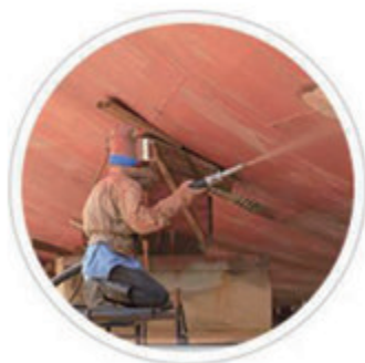
液体固体喷射清洗法 灵活度较高，但成本较高， 废液处理较复杂
